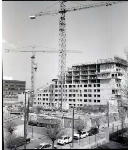
Construction de l'immeuble rue Étienne-Dolet (emplacement de la tribune sud-ouest) © Archives municipales de Saint-Ouen
