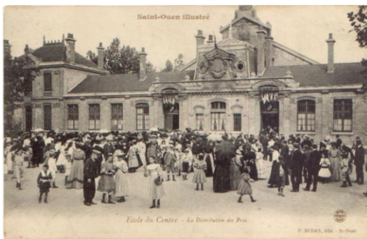
Construction en 1883 du Groupe scolaire du Centre sur la place des Écoles aujourd'hui la place Jean Jaurès, coll. Archives municipales de Saint-Ouen
