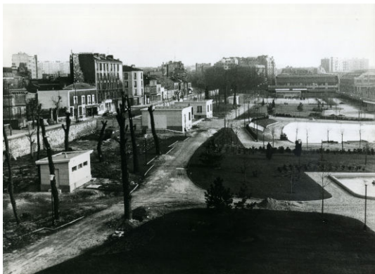
Parc Abel-Mézières pendant les travaux coll. Archives municipales de Saint-Ouen.
