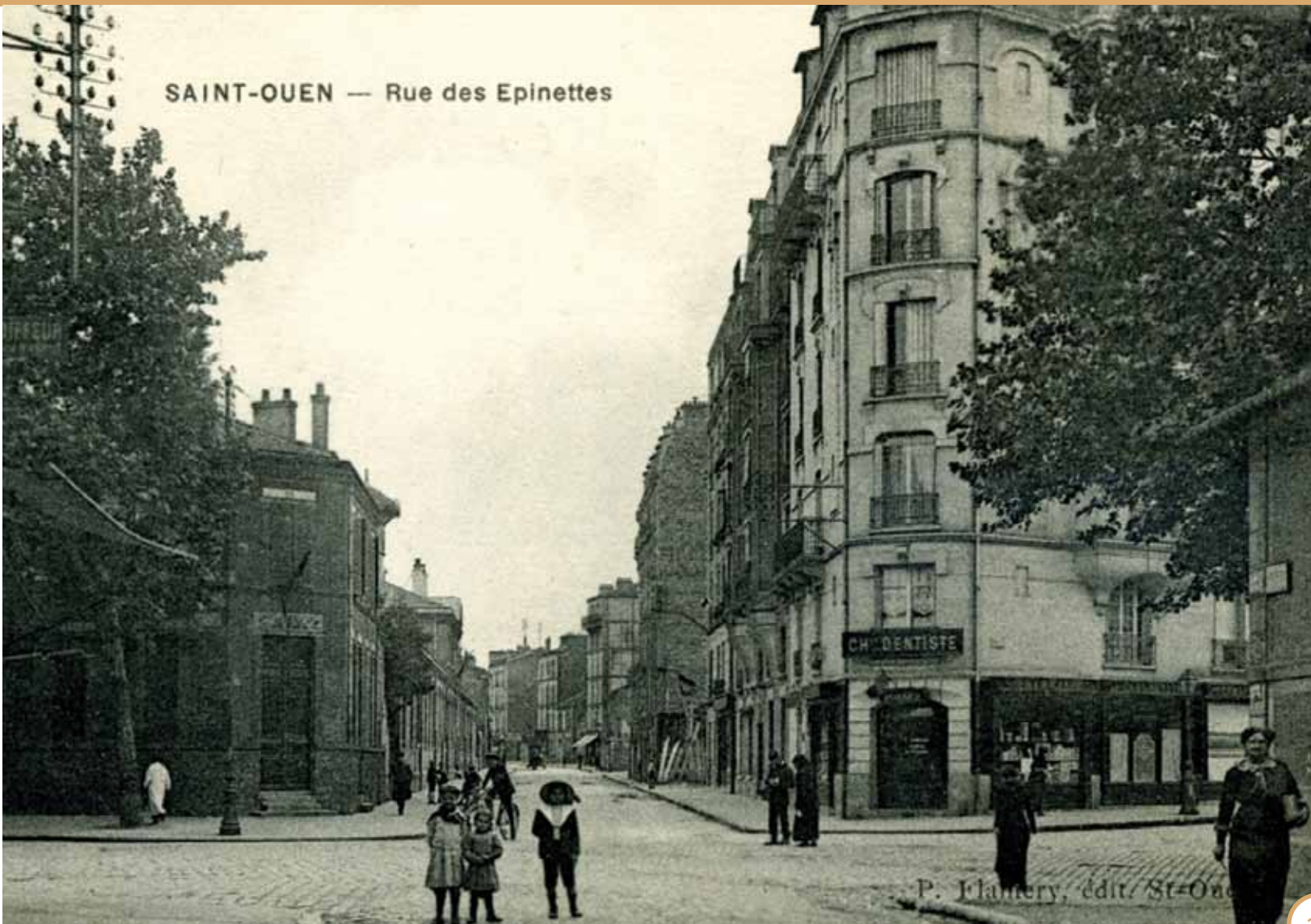
En face, la rue Emile-Zola ; à droite de la rue, l'immeuble construit avant-guerre par la Compagnie Générale Immobilière de Saint-Ouen ; à gauche de la rue, la crèche municipale Jean Monmousseau.
